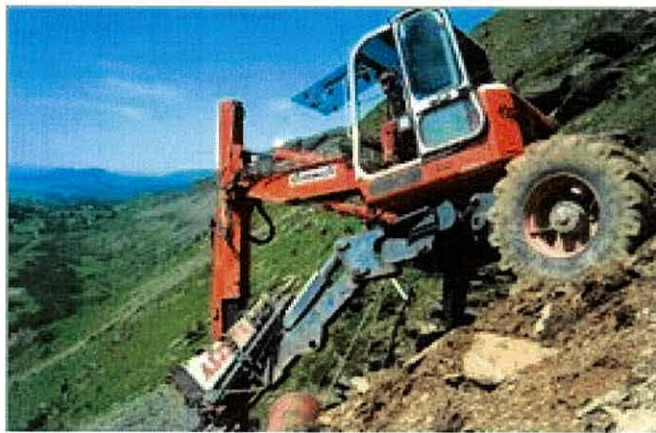
Ffigwr 5.3: Llun o'r claddwr wedi ei glymu i'r mynydd er mwyn claddu pibellau a gwifrau cynllun trydan dŵr Cwm Croesor yn 1999 (Dulas, 2007).
